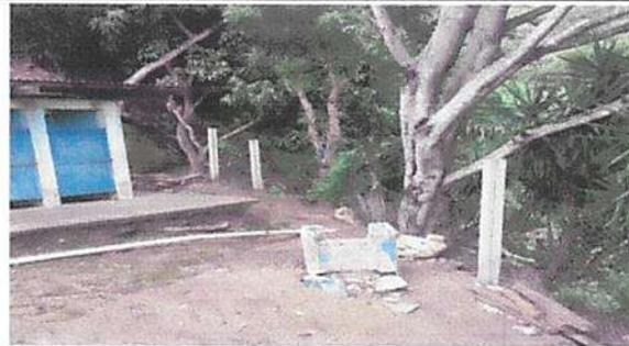
**Foto 1:** Sustitución de cerca con malla galvanizada 2 mts de alto y tubo galvanizado 1 1/2" con su respectivo bordillo y alambre de púa.
