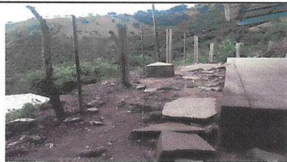
**Foto 3:** Sustitución de pavimento de concreto, con espesor de 6 centímetros.
